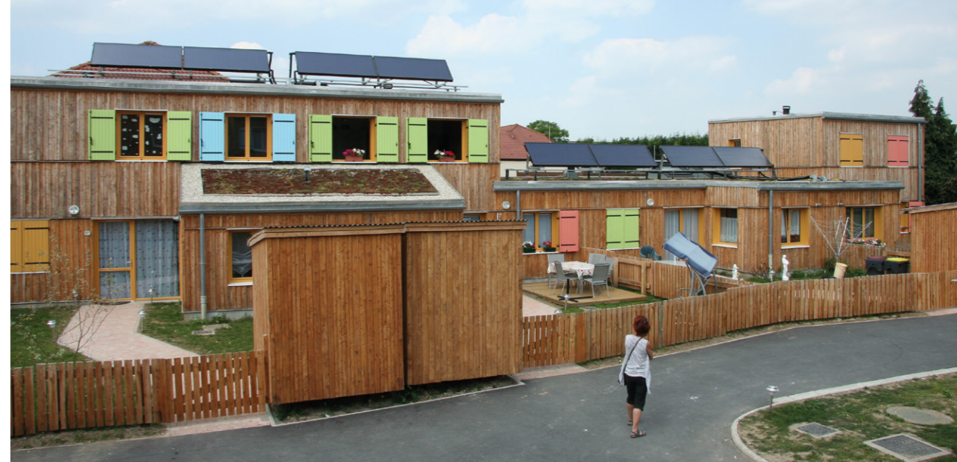
Écoconstruction de logements sociaux en 2010 par une entreprise qui emploie et forme des personnes éloignées du marché du travail à Loos-en-Gohelle, dans le Pas-de-Calais.
